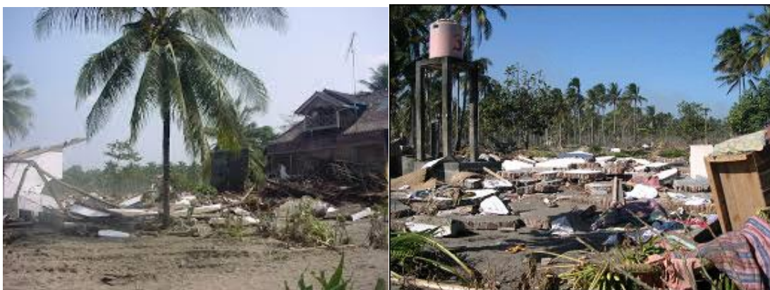
Gambar 3.15 Dampak tsunami yang melanda Pangandaran, Juli 2006
