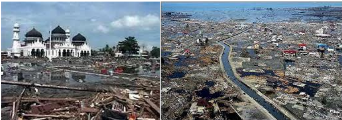
Gambar 3.14 Dampak tsunami yang melanda kota Banda Aceh Desember 2004
