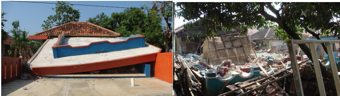
Gambar 3.5 Dampak Gempabumi yang melanda Tasikmalaya September 2009
